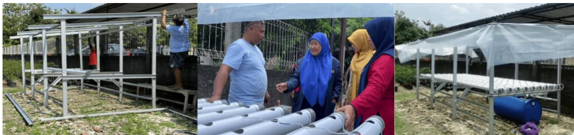
Gambar 5. Kegiatan pemasangan instalasi hidroponik
