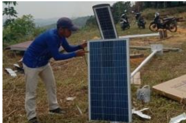
Gambar 3. Kegiatan perakitan lampu penerangan panel surya
