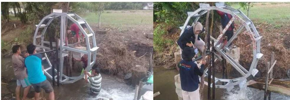
Gambar 5. Proses instalasi kincir air
