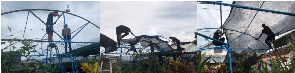
Gambar 10. Memasang kerangka besi dan paranet
