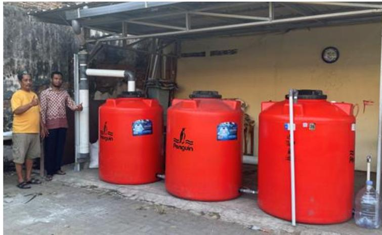
Gambar 5. *Rainwater harvesting* telah siap digunakan
