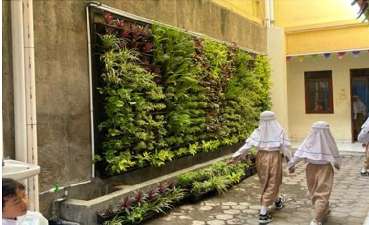
Gambar 6. *Vertical garden* yang dilengkapi dengan kolam kecil untuk *circular water* dan *ground water tank*
