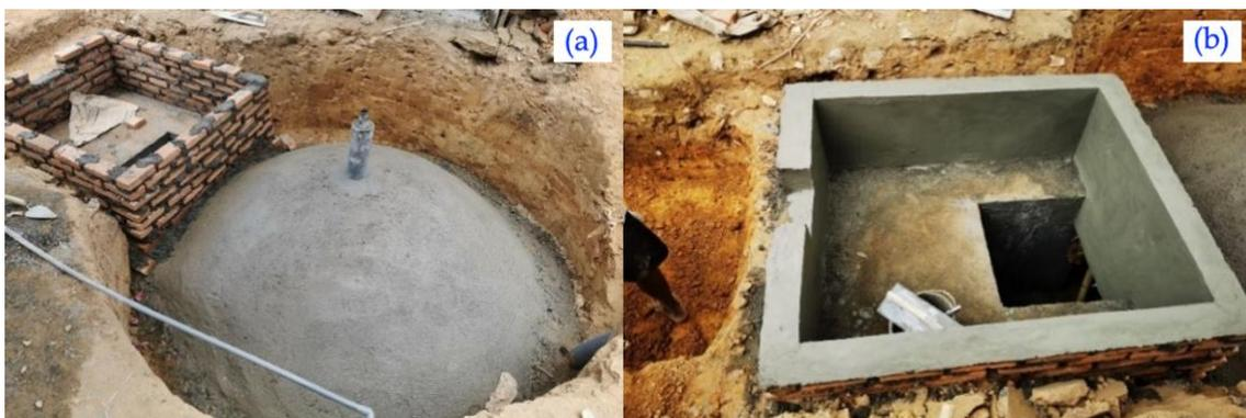
[Gambar 2](#). Proses (a) pembuatan kubah yang bagian atasnya dilengkapi pipa besi dan (b) pembuatan saluran keluar sisa proses biogas (*slurry*)
