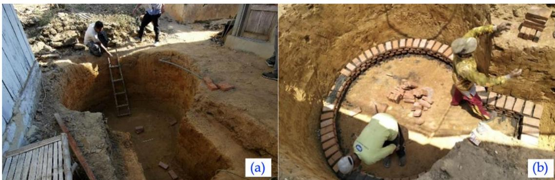
Gambar 1. Proses (a) pengerukan tanah dan (b) pembuatan fondasi
