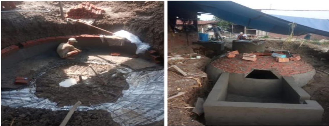
Gambar 6. Pembangunan reaktor biogas untuk energi yang terbarukan
