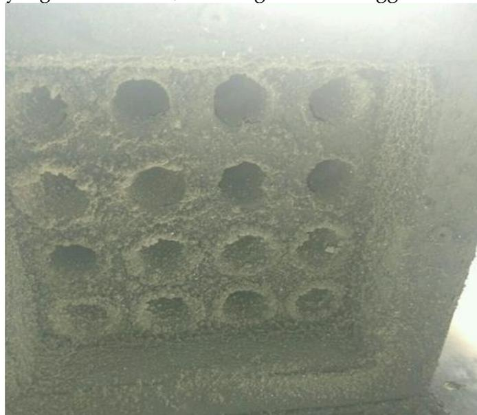
**Gambar 11.** Heat Exchanger yang kotor, perlu pembersihan
