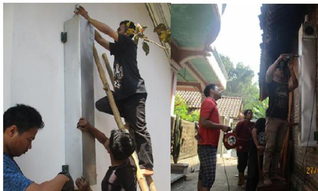
**Gambar 9.** Proses pemasangan Heat exchanger (KWT. Ngudi Mulyo dan KWT. Rahayu Manunggal)
