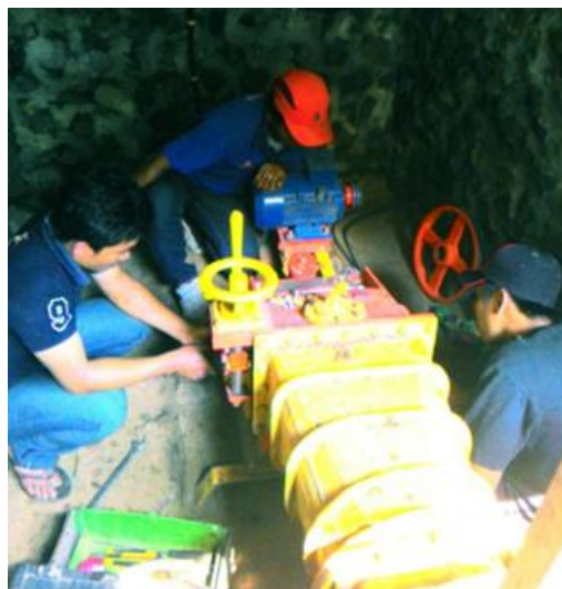
Gambar 7. Pemasangan Mikrohidro dan Instalasi Mekanik
