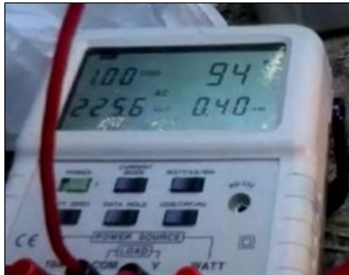
Gambar 10. Hasil pengukuran comissioning kelistrikan
