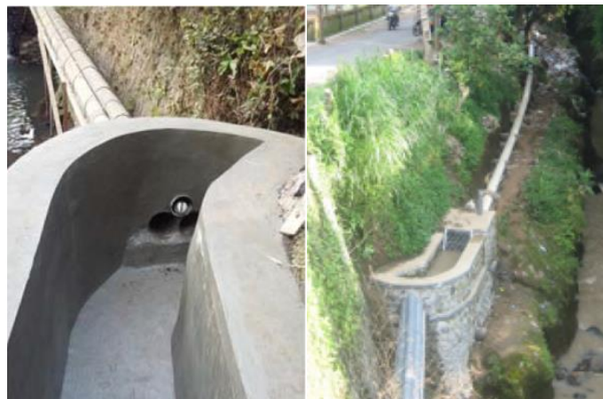
Gambar 5. Pembuatan Saluran Air dan Bak Penyaring Air
