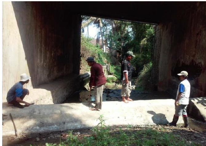
Gambar 4. Pembuatan intake bendungan
