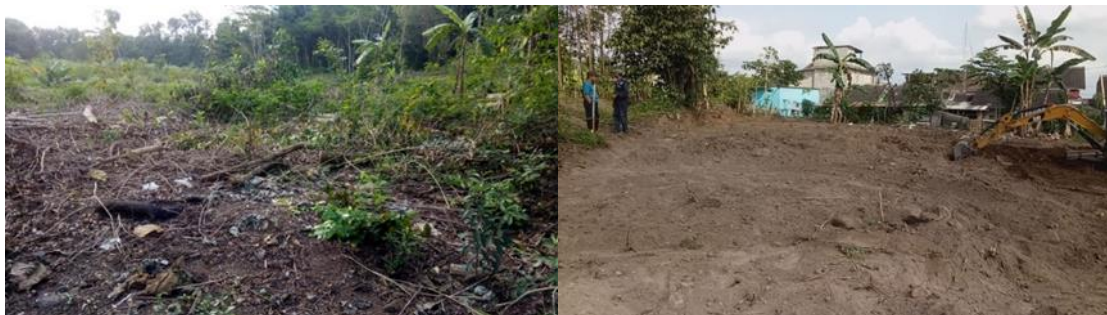
Gambar 4. Pembukaan lahan dan pengolahan tanah
