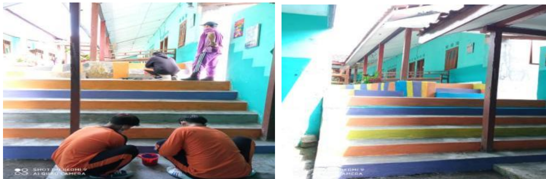
Gambar 8. Pengecatan fasilitas sekolah untuk mendukung program MGS
