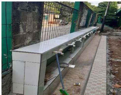
Gambar 1. Proyek pembuatan tempat cuci tangan sudah selesai
