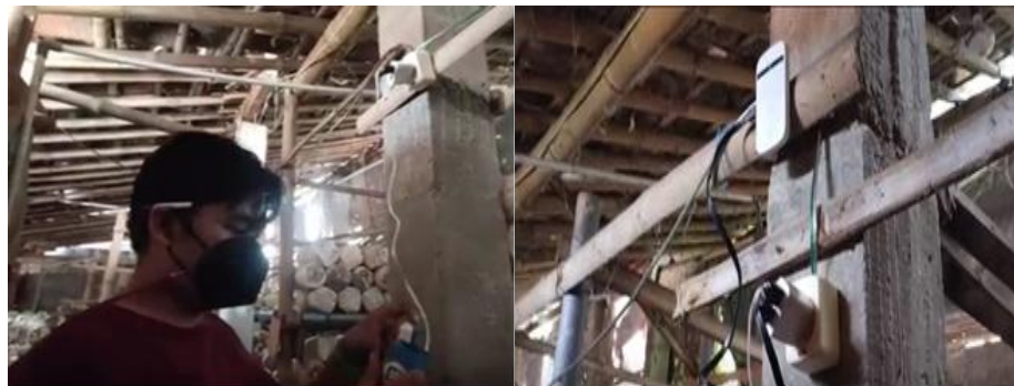
Gambar 11. Instalasi modul IoT dan Internet di rumah produksi jamur
