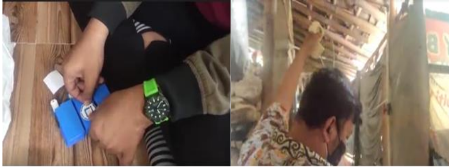
Gambar 10. Persiapan modul IoT dan instalasi listrik
