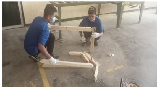
[Gambar 11](#). Proses perakitan dan penyambungan pen ke lubang pada kayu
