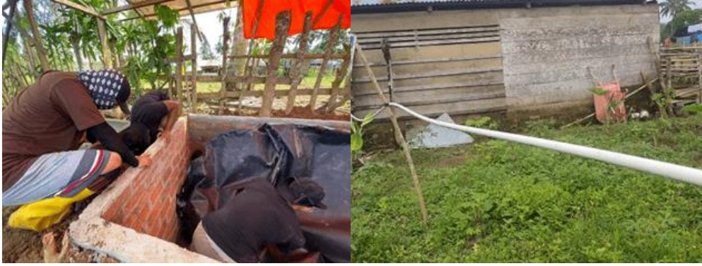
Gambar 7. Pemasangan pipa ( inlet, outlet dan gas )
