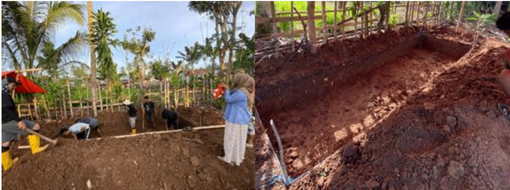
Gambar 5. Pembuatan lubang galian digester
