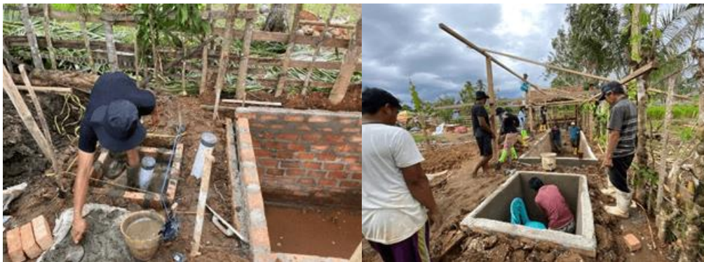
Gambar 6. Pembuatan lubang inlet dan outlet
