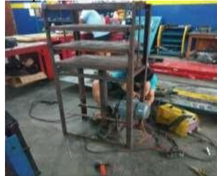
Gambar 13. perakitan instalasi kelistrikan
